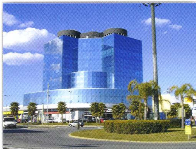
Edifici EUROPA • Vilanova
